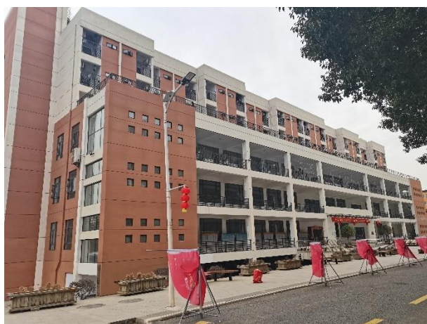
图 21 新建综合楼实景
